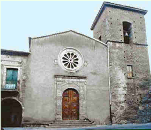
Caccuri – Chiesa di Santa Maria del Soccorso adiacente al Convento inizialmente dei Domenicani. Sulla destra della navata unica si apre la Cappella Cavalcanti che aveva anche un ingresso privato dall'esterno, oggi murato.
